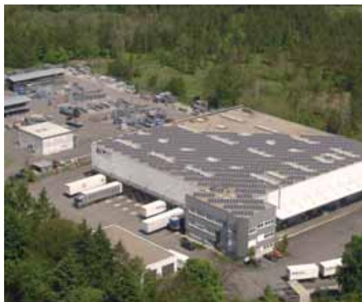
**Auf dem Dach der BKV-Logistikanlage hat Heinz O. Fischer 2004 eine Photovoltaikanlage installieren lassen. Investitionsvolumen: Rund eine Million Euro. „Wir speisen rund 200.000 Kilowattstunden jährlich ins öffentliche Netz ein“, berichtet der BKV-Geschäftsführer. „Unsere LKWs blasen einiges an Schadstoffen in die Luft – mit den Solarpaneelen will ich im Gegenzug einen Beitrag zum Klimaschutz leisten.“**
