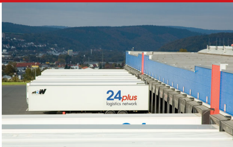
Der Blick Richtung Norden: Dort wird der Erweiterungsbau entstehen.
