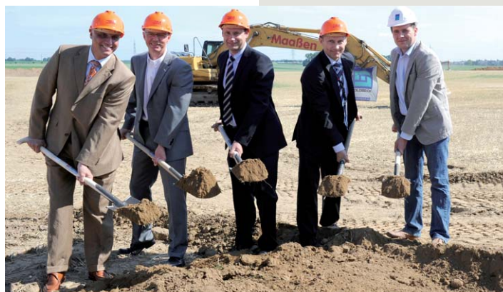
Beim ersten Spatenstich (v.l.): Friedhelm Kleine, Bürgermeister Harald Zillikens, Dietmar Lackmann (3M), Dirk Scholz (3M), Ralf Kockmann (Goldbeck-Bau).
