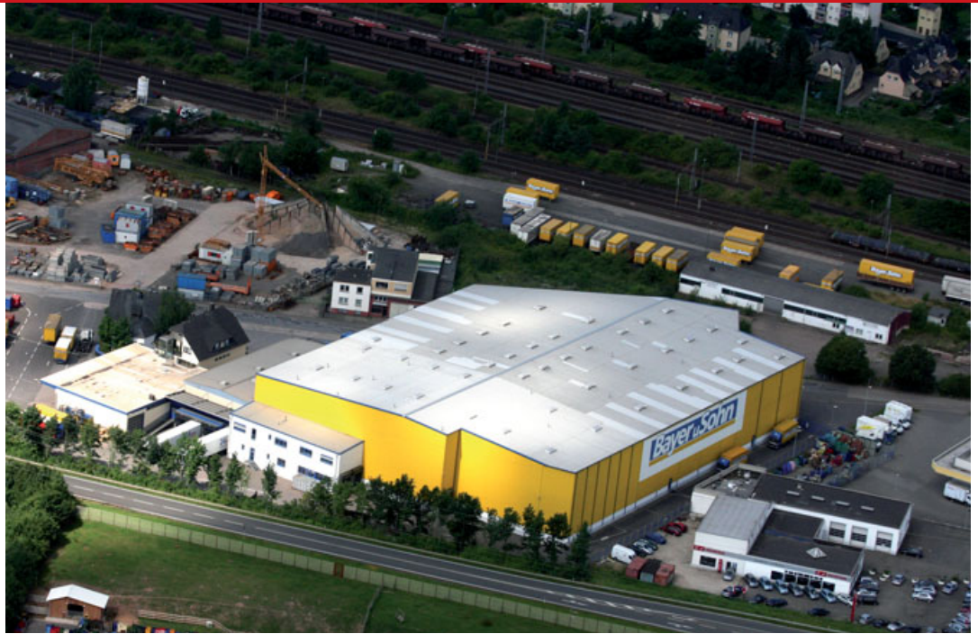
Multimodale Anbindung im GVZ Trier.
